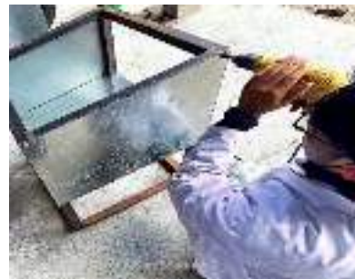
Fig. 5. Colocación de lámina
