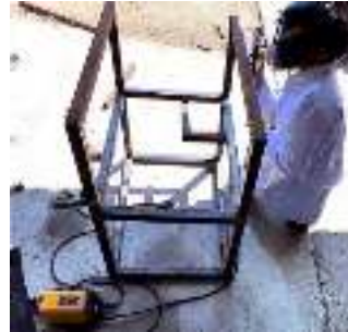
Fig. 3. Soldadura en costados
