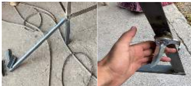
Figura 30. Corte y soldado de la estructura
