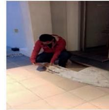
**Figura 4. Corrección de imperfecciones con lija**
