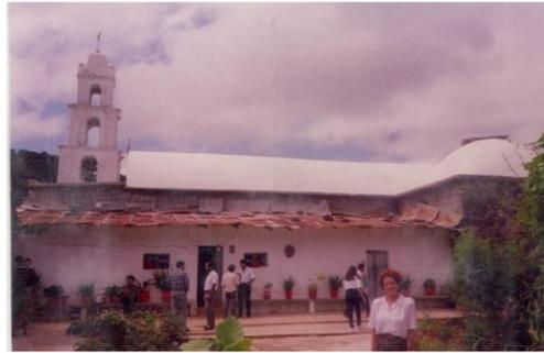
Figura 3. Bóveda y Domo hechos de ferrocemento
