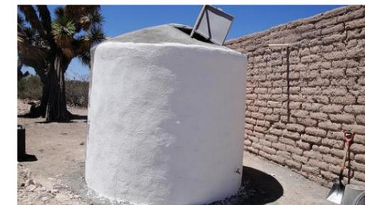
**Figura 2. Cisterna de Ferrocemento**
