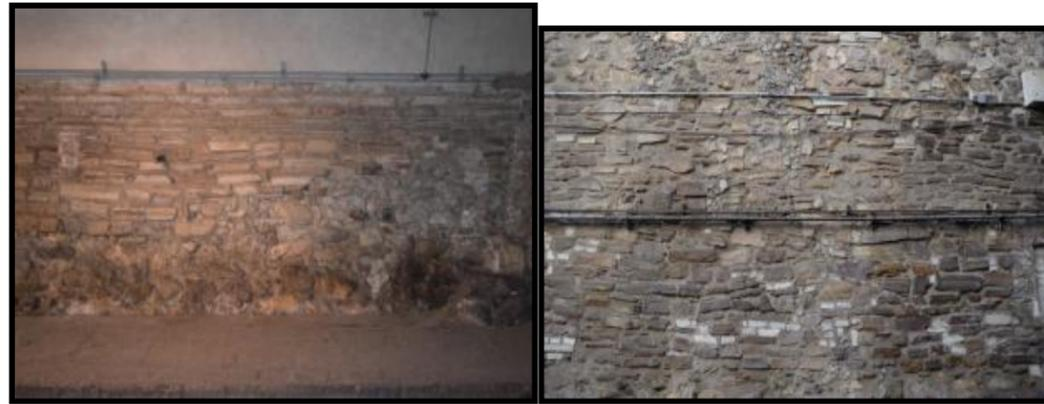
**Ilustración 3. Muro cimentación del mesón. Puede apreciarse el acomodo de la mampostería y la forma predominante de las piedras que constituyen el muro.**
