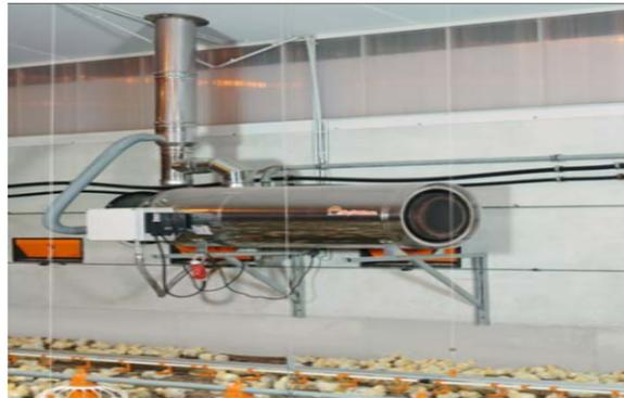
Figura 1. Calefactor de gas con chimenea
