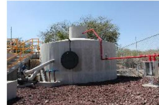
Figura 1. Reactor Anaeróbico del Sistema Híbrido.
