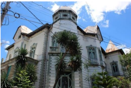
Figura 1. Visitas de campo “Casa de la Presa No. 97”
